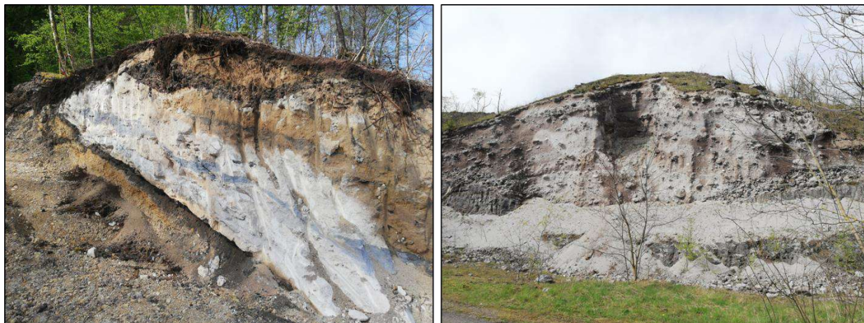
Illustration 24 : Profils verticaux au sein des formations de crassier présentant des sables indurés
